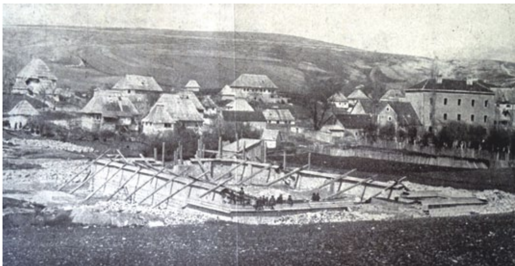
■ Polaganjem kamena temeljaca u ljeto 1924. počela je gradnja duvanjske spomen-crkve, a već do polovine 1925. dovršeni su njezini temelji. Fotografija je objavljena u Zagrebačkom ilustrovanom listu , broju 36. iz jeseni 1925. godine.
